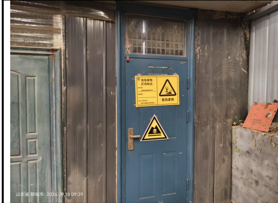
危废暂存间外部
